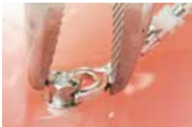
5 Aufschieben des C-Clips
